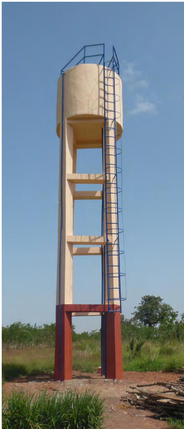
La torre di raccolta dell'acqua.
