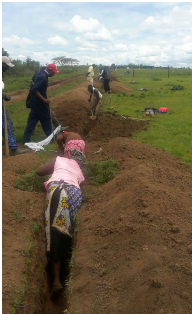
Lo scavo per condotte idriche.
