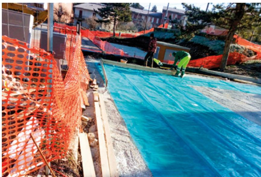
Sopra: La predisposizione della piattaforma su cui assemblare la "nostra" struttura.
